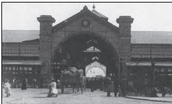
"Mercado Viejo", ca. 1900. En: Kozak Daniel (2014) Construcción y transformaciones del Abasto, 1889-1998 . Centro de Estudios Urbanos y Regionales (CEUR-CONICET)
