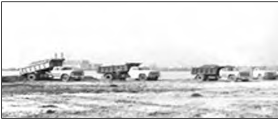
Descarga de escombros en el Río de la Plata
