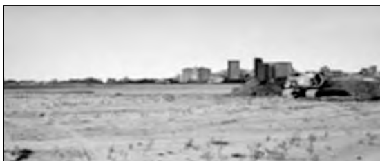
Relleno de terrenos, 1980
