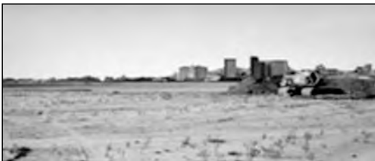
Relleno de terrenos, 1980
